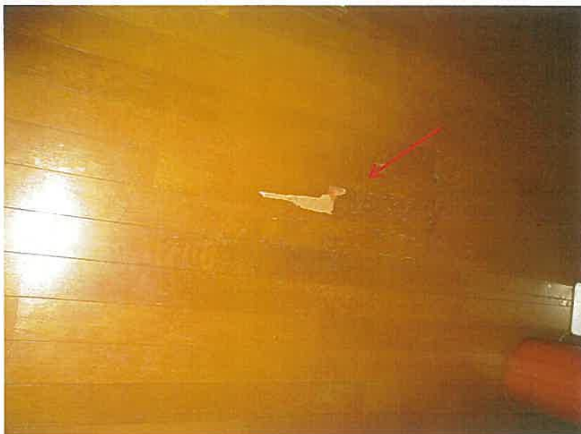
「写真」 1階フローリングの状況
