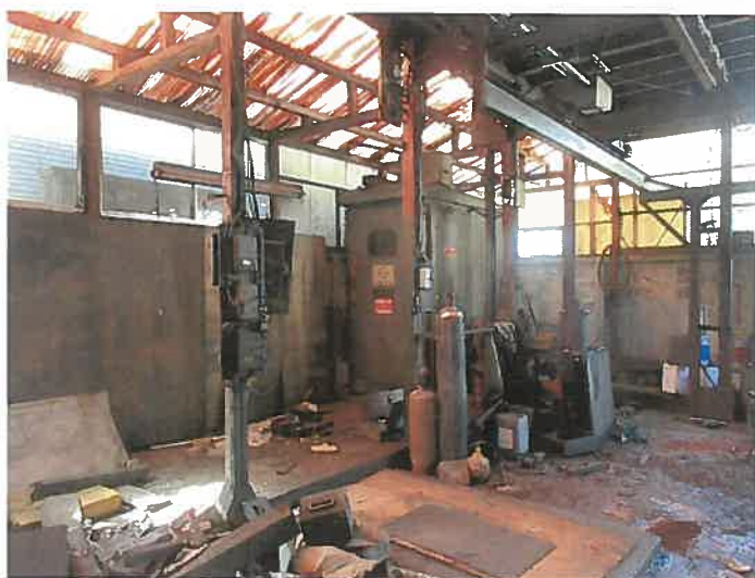
※ 1 階工場の現況
