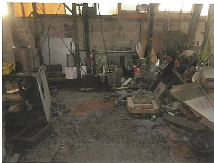
※ 1 階工場の現況
