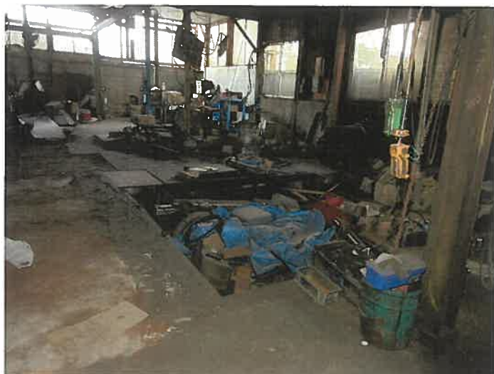
※ 1 階工場の現況
