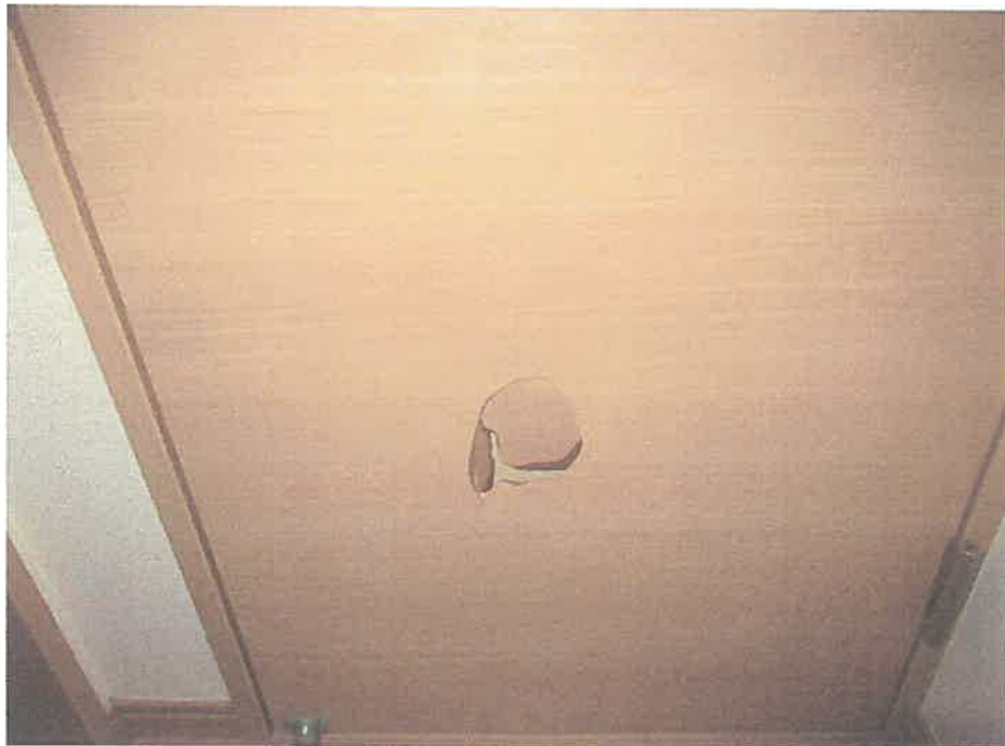
1階トイレの入口ドアの損傷
