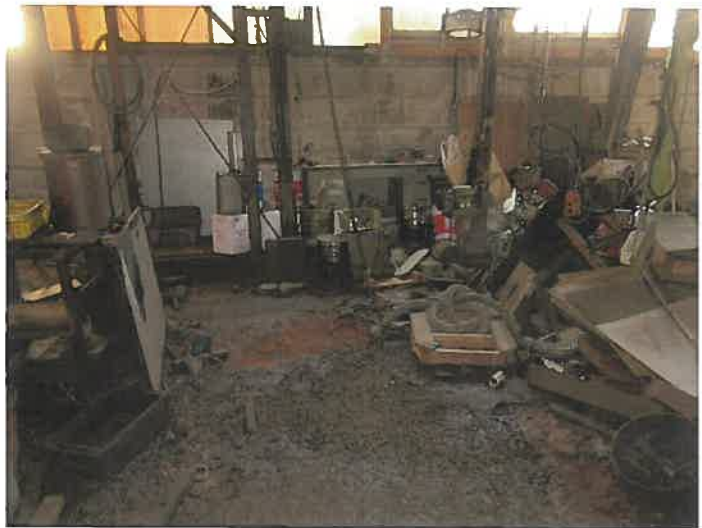
※ 1 階工場の現況
