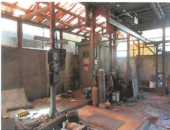
※ 1 階工場の現況
