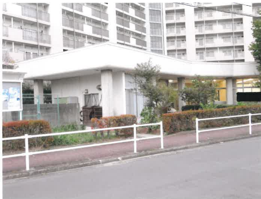
⑪ 物件 6（建物－集会所）北西側から撮影
