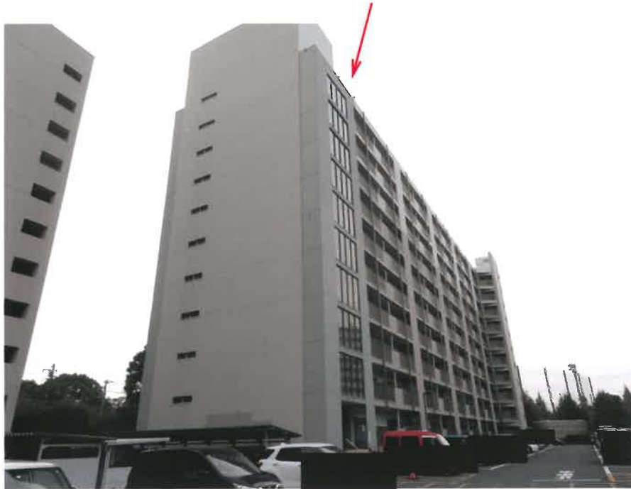
⑦ 物件2一棟の建物の外観（東側から撮影）
