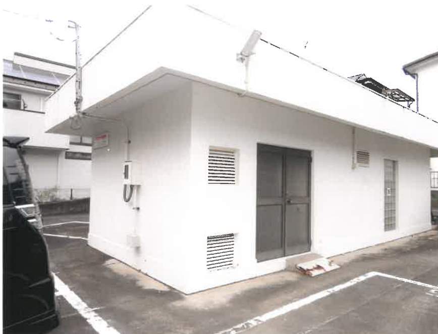
⑨ 物件4（建物－機械室）（南西側から撮影）
