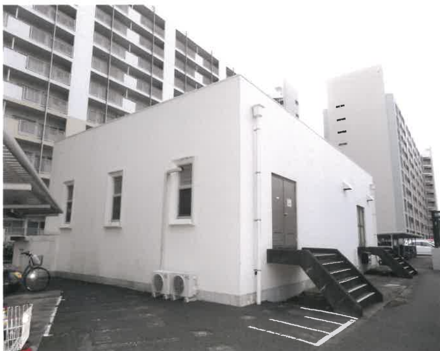
⑩ 物件5（建物－電気室 ポンプ室）（北東側から撮影）
