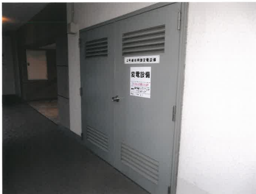
⑧物件2（建物－電気室 機械室）（北西側から撮影）
