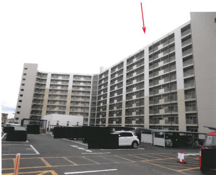
① 物件1・物件3一棟の建物の外観（北西側から撮影）
