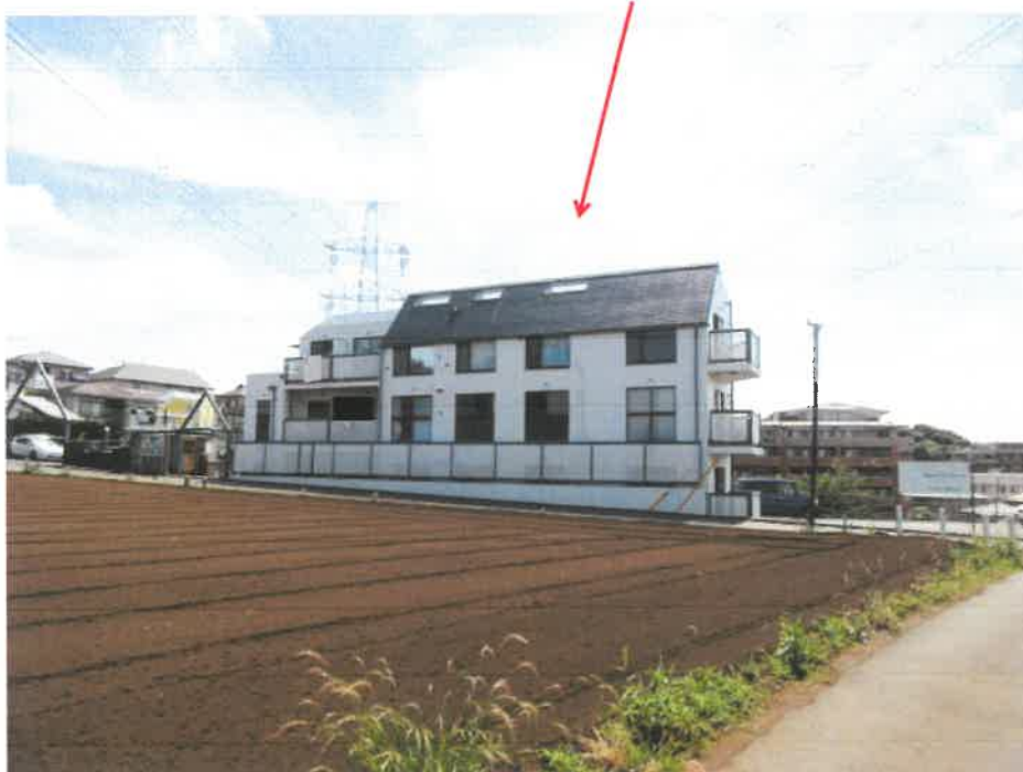
物件 1 の存する一棟の建物
