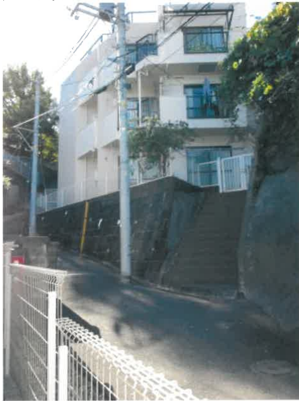
① 建物の外観
