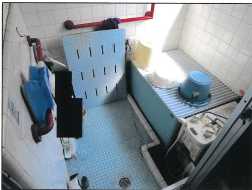
④ 建物内の状況ー浴室(1階)
