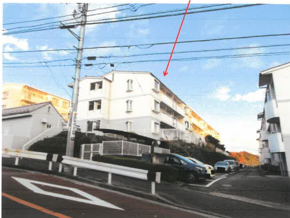
物件 1 の存する一棟の建物
