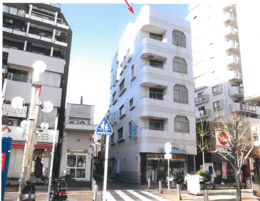
① 建物の外観（南東側から撮影）
