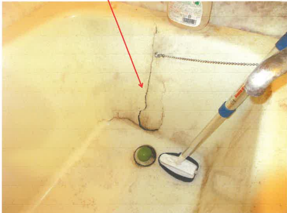
風呂桶の損傷状況
