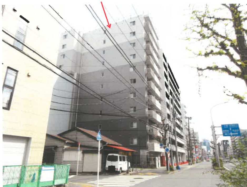
物件 1 の存する一棟の建物
