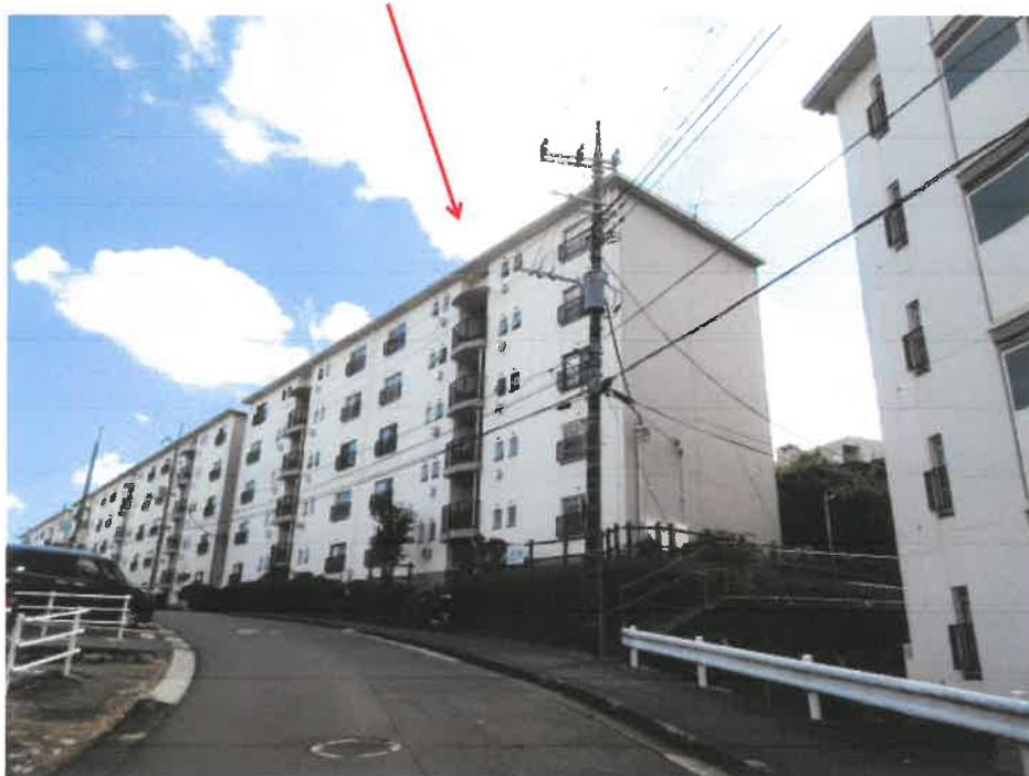
物件 1 の存する一棟の建物
