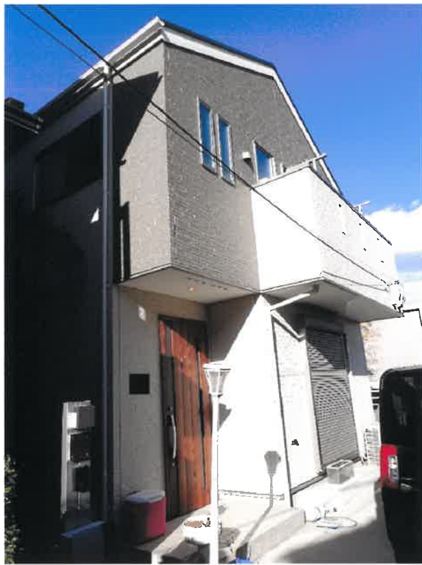
① 物件 6 建物南西側の状況
