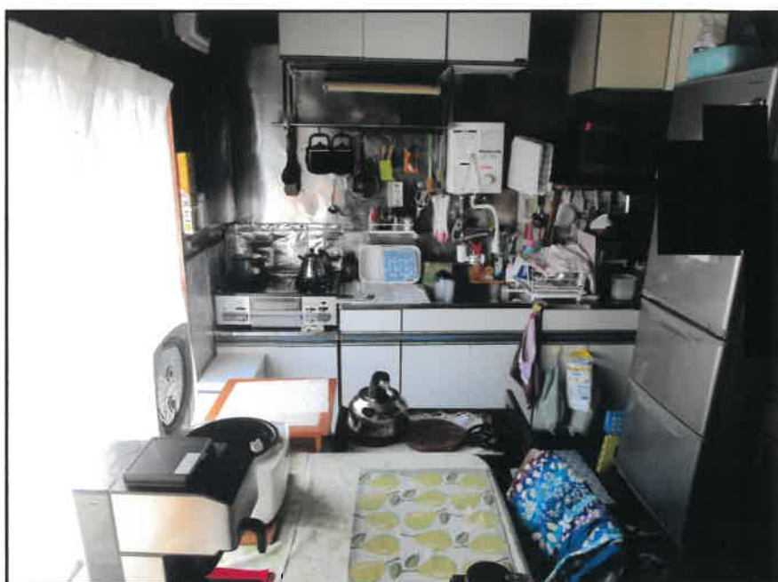
④ 建物内の状況－DK(1階)
