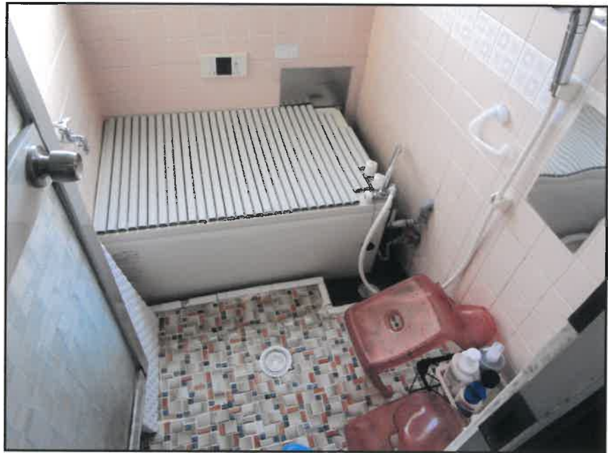
⑤ 建物内の状況－浴室(1階)
