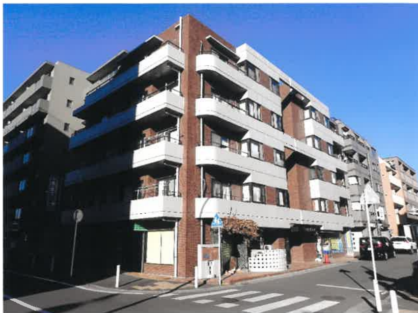
① 目的物件南西側の状況
