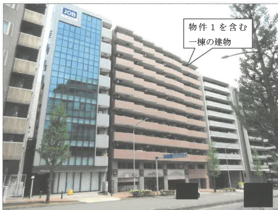
①外観（南方向から撮影）
