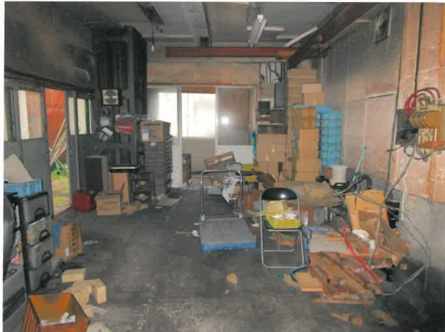
⑦ 建物内の状況 物件5の1階
