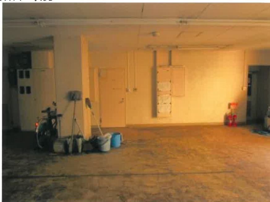
③ 建物内の状況
