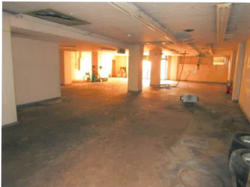
② 建物内の状況
