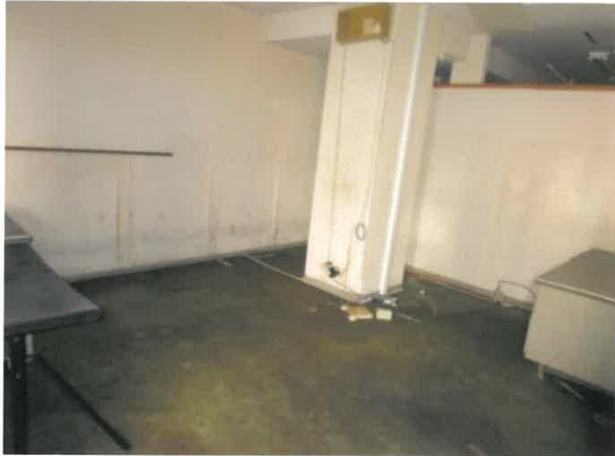
⑥ 建物内の状況
