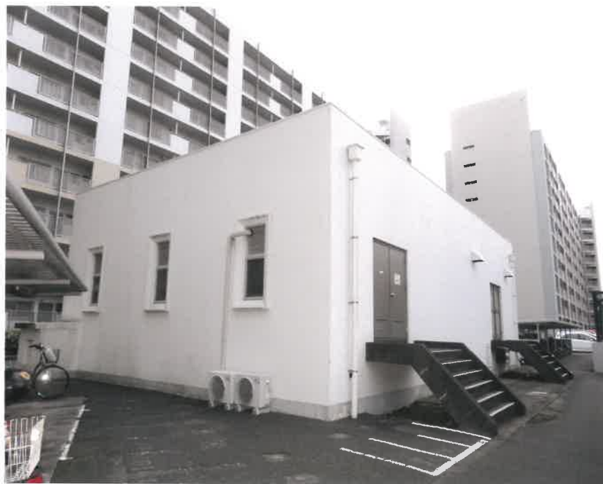
⑩ 物件5（建物－電気室 ポンプ室）（北東側から撮影）
