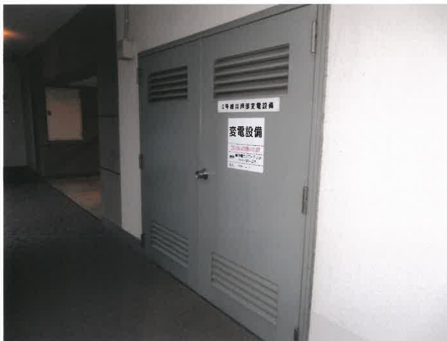
⑧物件2（建物－電気室 機械室）（北西側から撮影）
