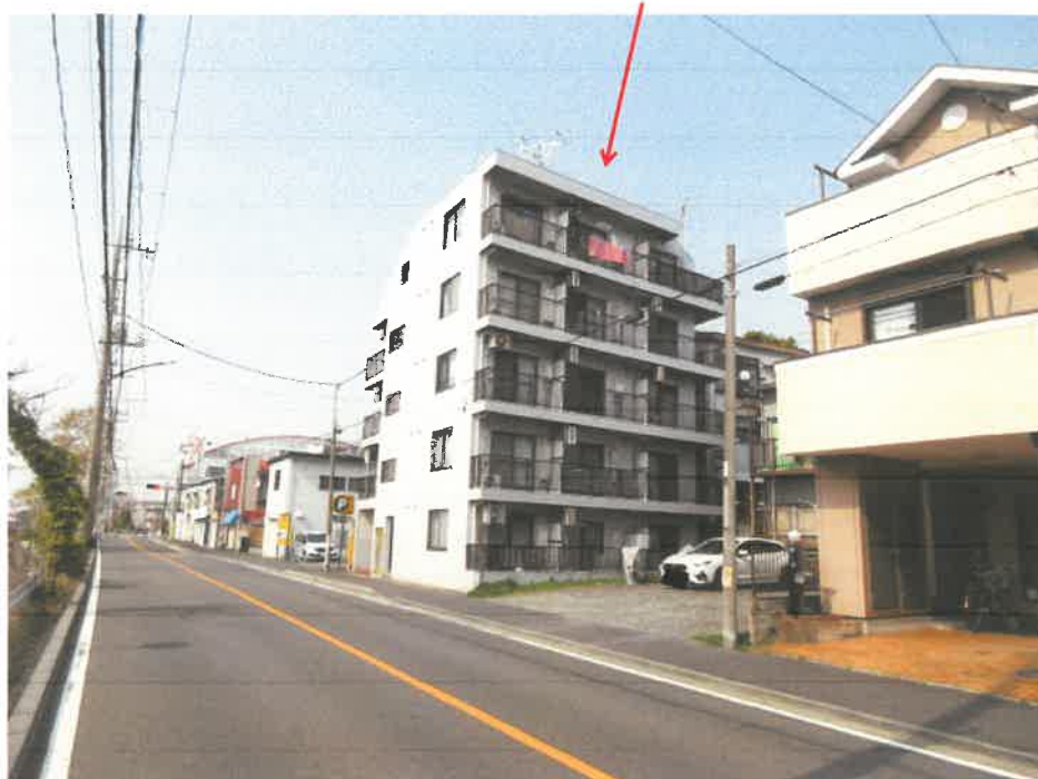
物件 1 の存する一棟の建物
