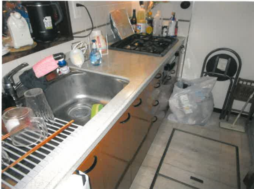
③ 建物内の状況
