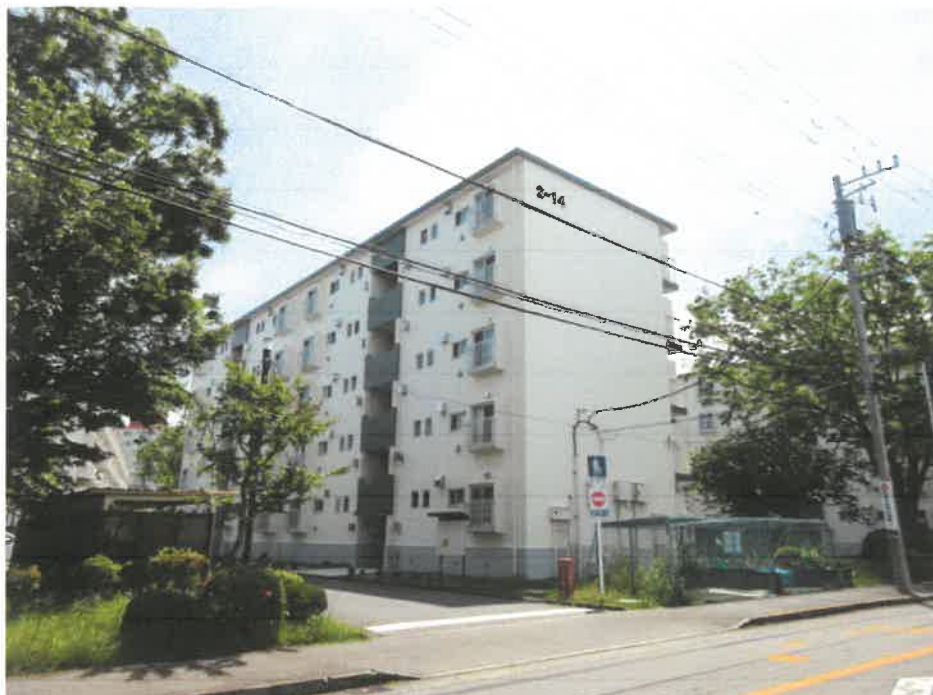
物件 1 の存する一棟の建物
