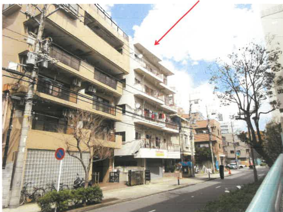
物件 1 の存する一棟の建物
