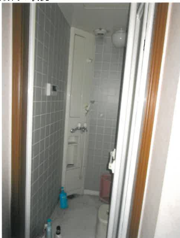
⑥ 建物内の状況
