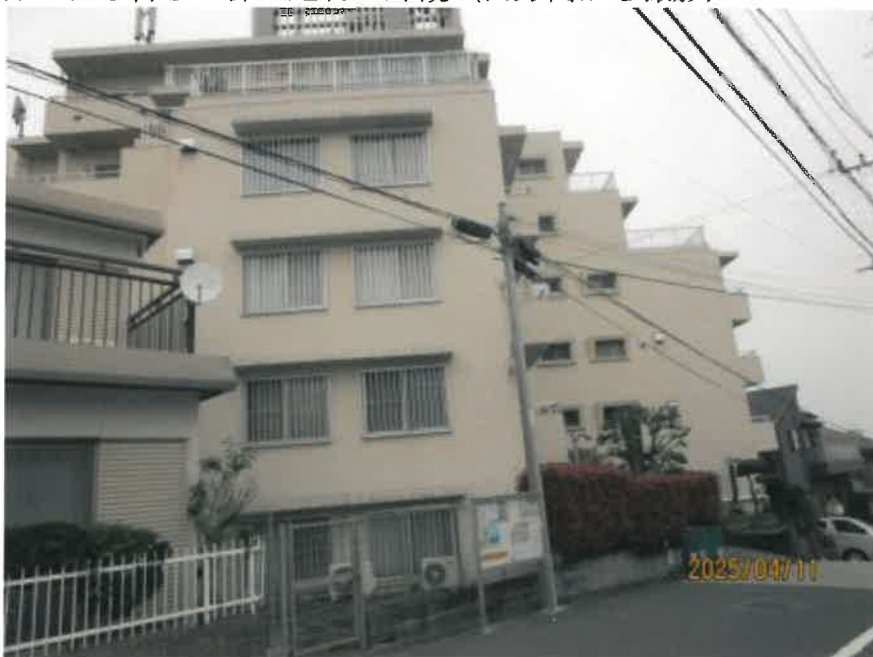
① 本件建物を含む一棟の建物の外観（西方向から撮影）
