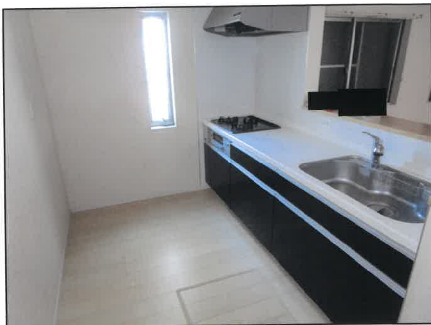
③ 建物内の状況ーキッチン(1階)
