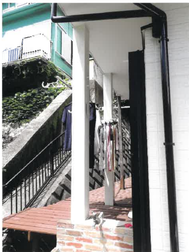
⑥ベランダ下の補強柱（手前の白色2本）
