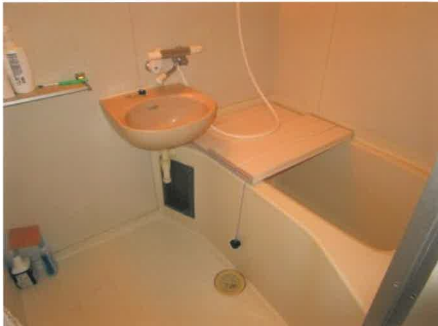
④ 建物内の状況
