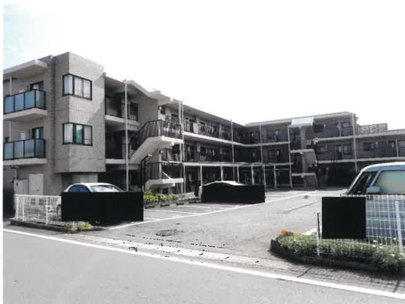
① 目的物件北東側の状況
