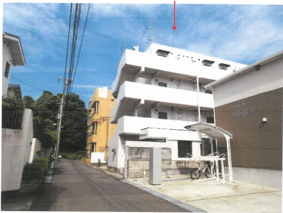
物件 1 の存する一棟の建物
