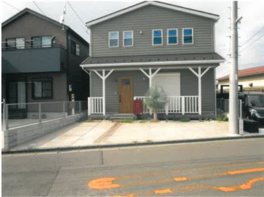
① 建物の外観
