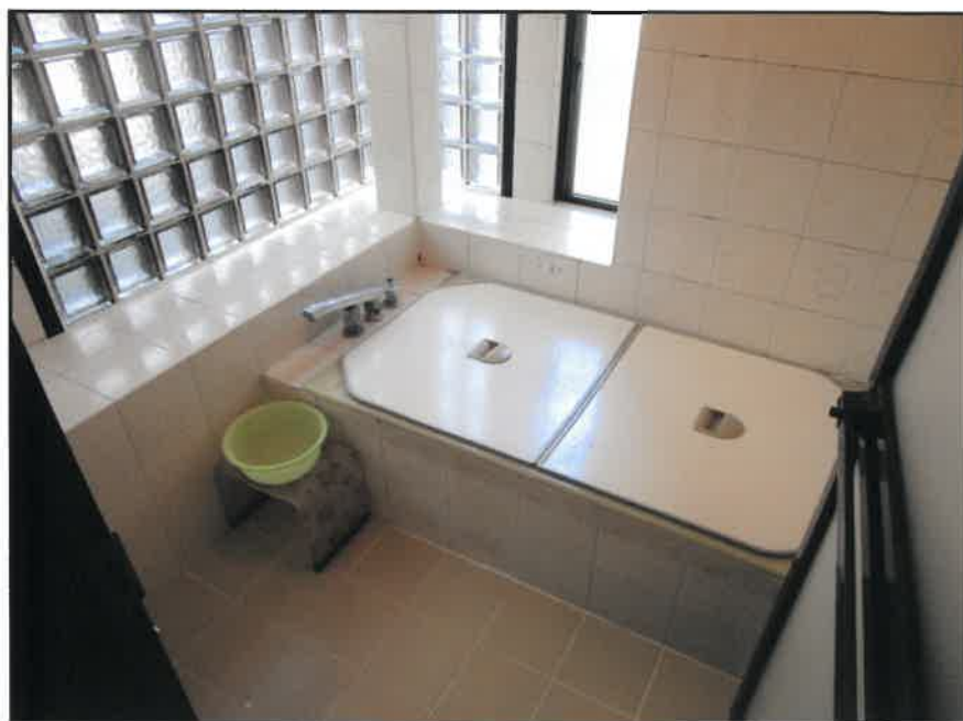
⑥ 建物内の状況ー浴室(1階)
