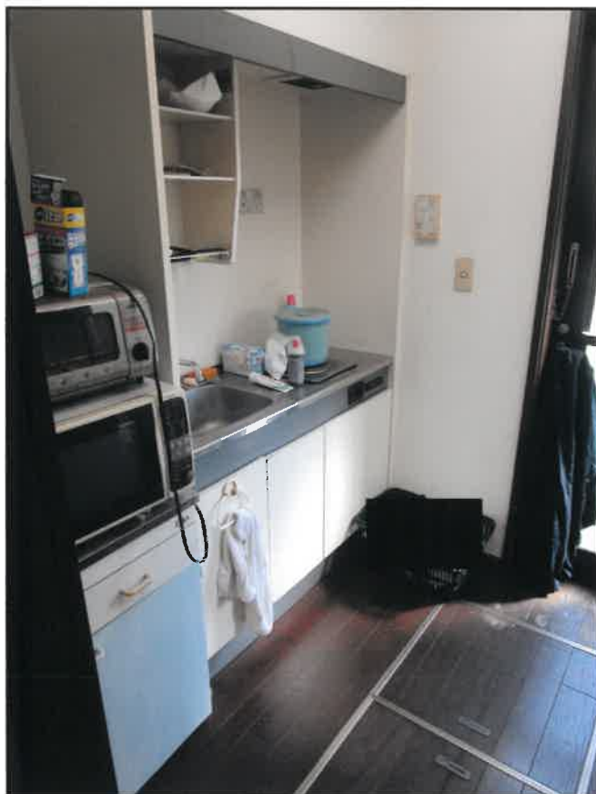
⑤ 建物内の状況ーミニキッチン(1階)
