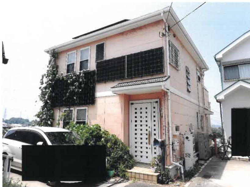
① 目的物件 3 建物南東側の状況
