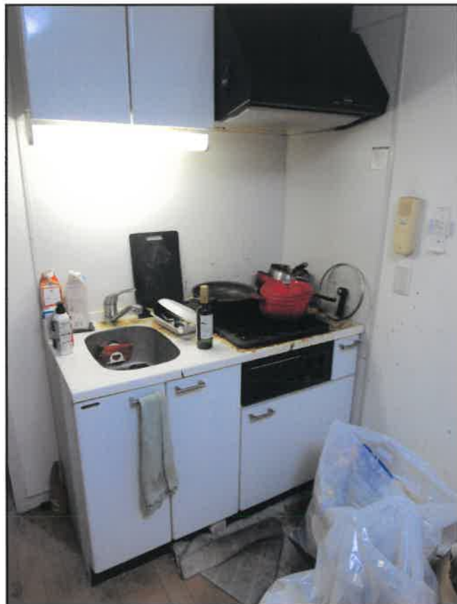
③ 建物内の状況ーキッチン(1階)
