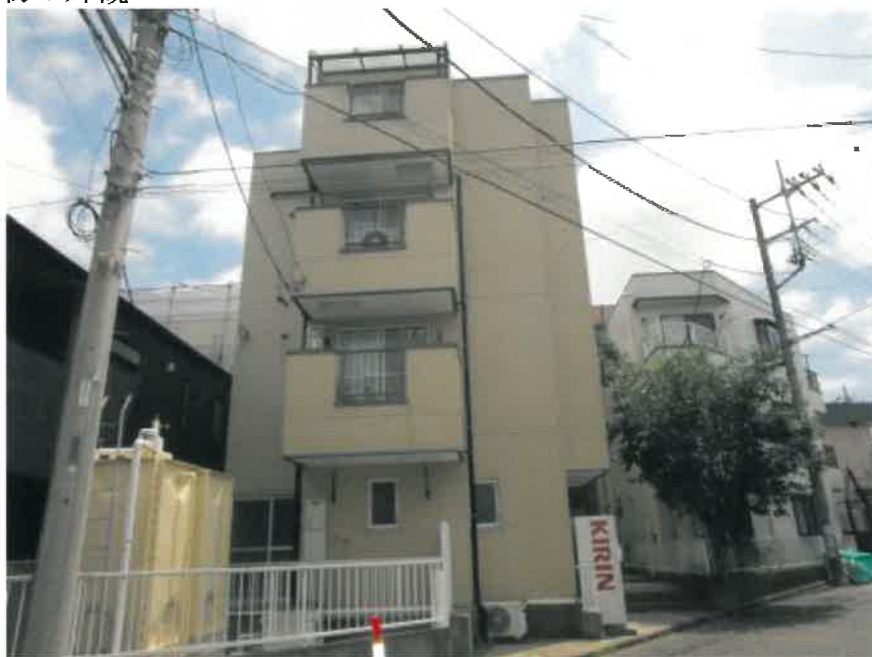
① 建物の外観
