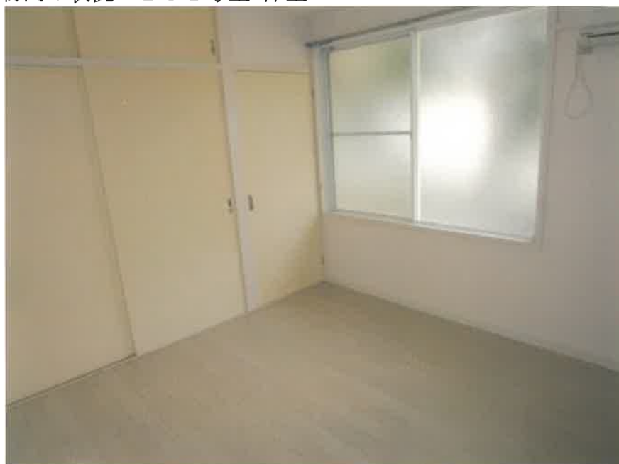
② 建物内の状況 101号室 洋室
