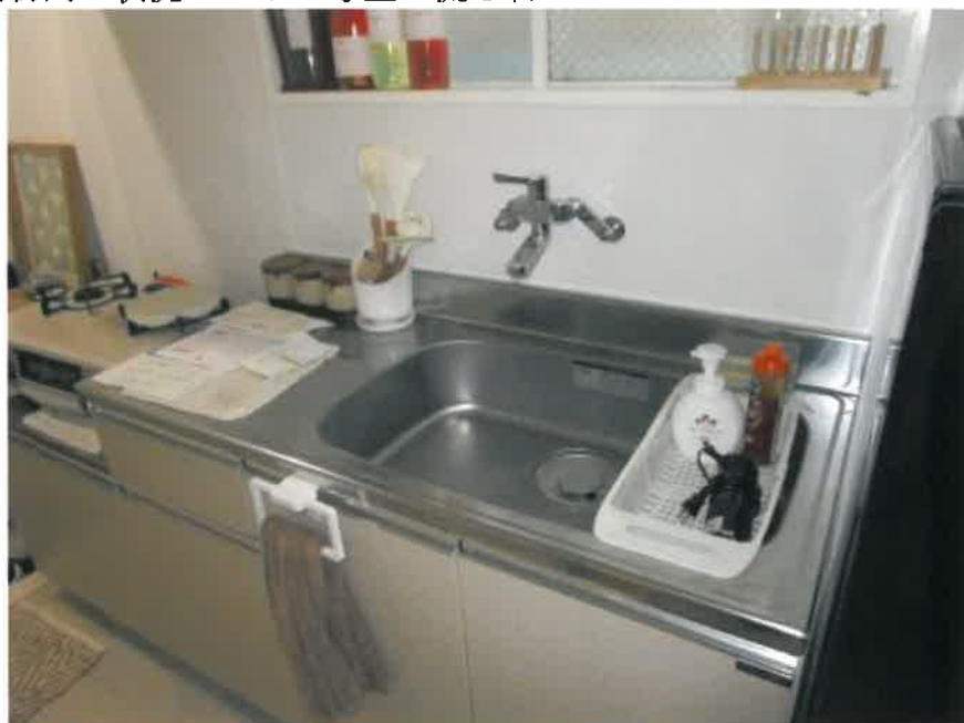
⑥ 建物内の状況 103号室 流し台
