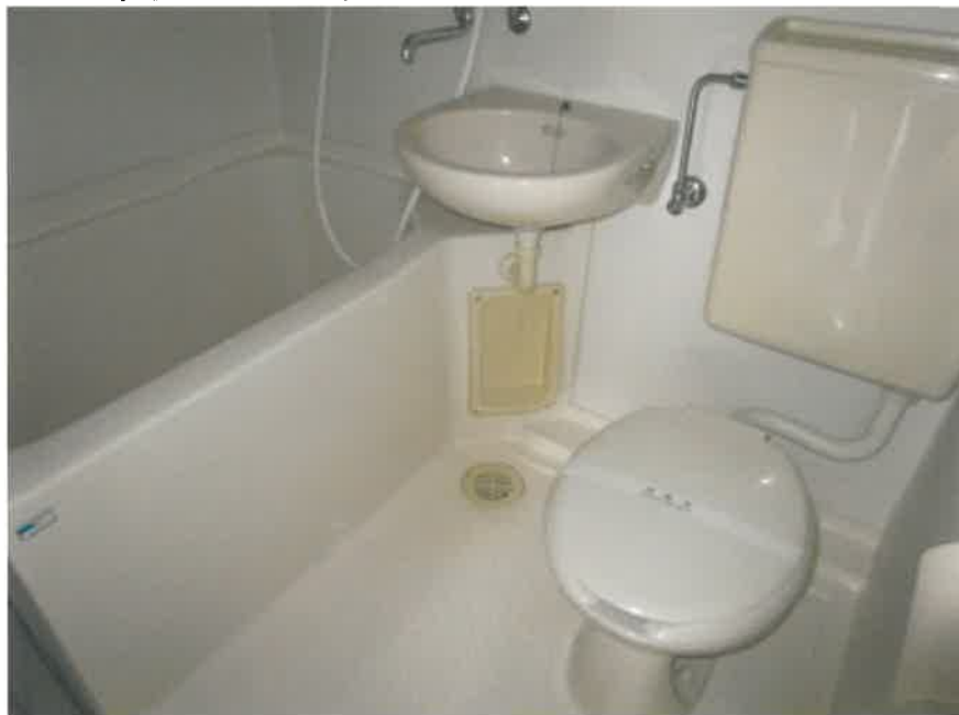
④ 建物内の状況 101号室 3点UB
