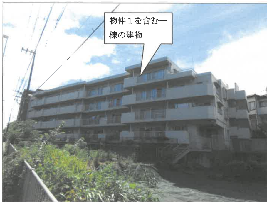
①外観（東方向から撮影）
