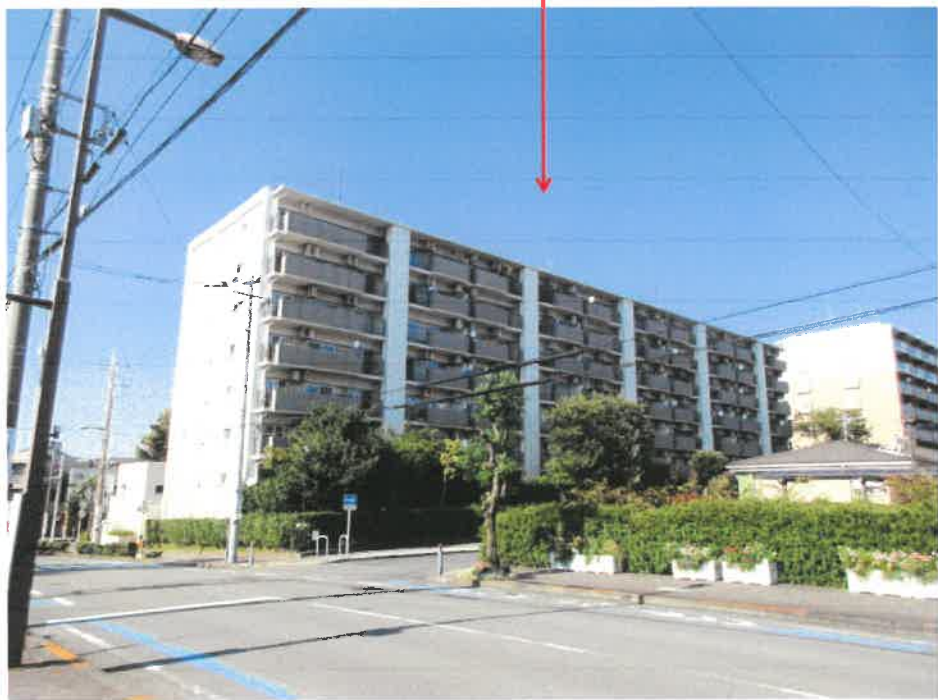
物件 1 の存する一棟の建物
