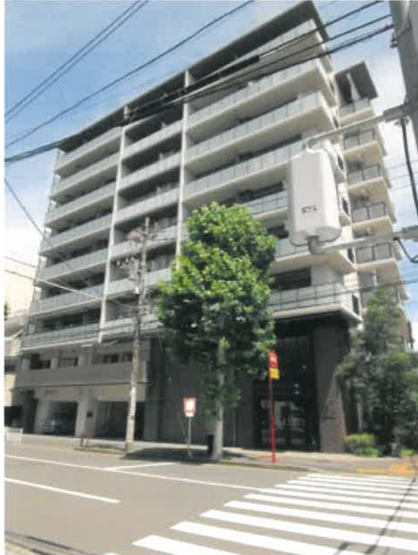
① 本建物を含む一棟の建物の外観（西方向から撮影）
