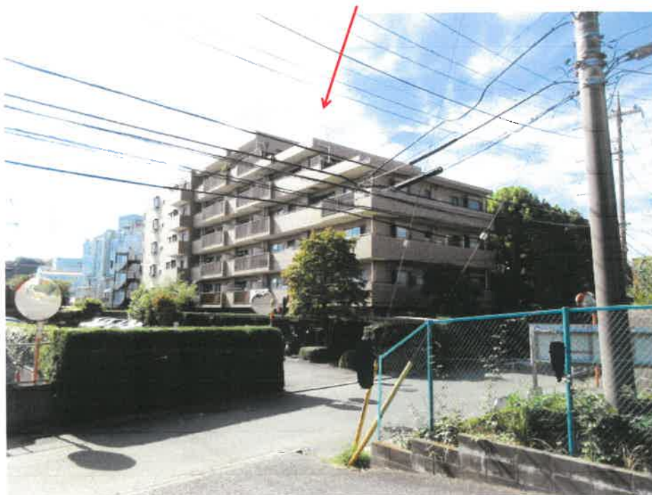
物件 1 の存する一棟の建物
