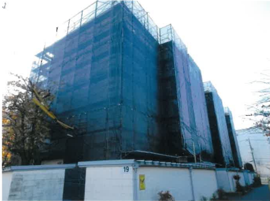
大規模修繕工事中
