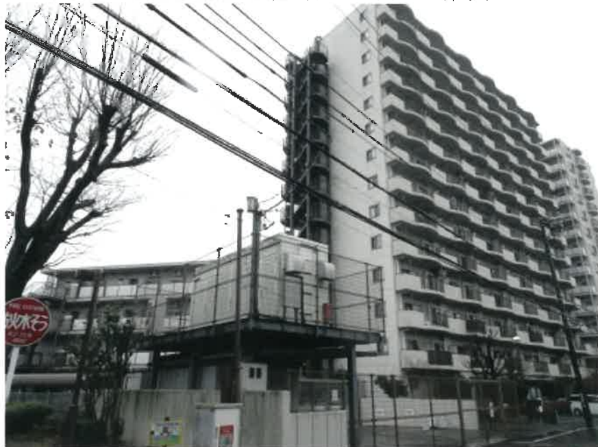
① 本建物を含む一棟の建物の外観（北西方向から撮影）
