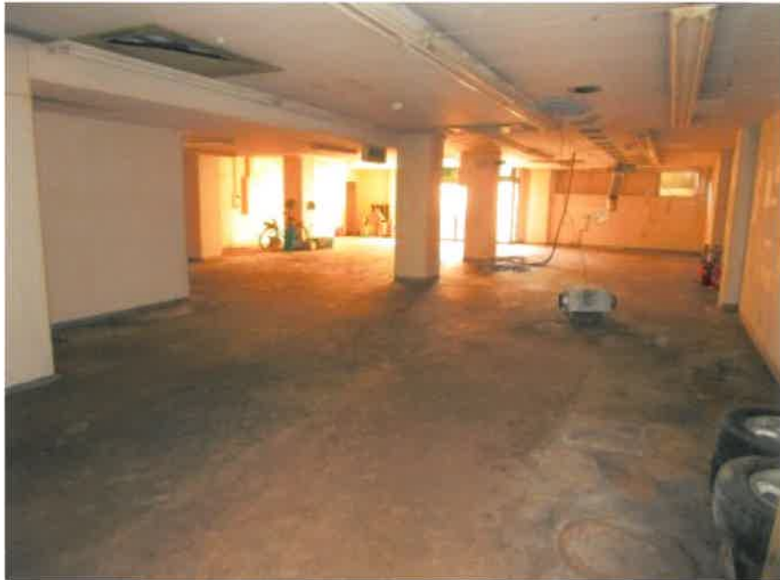
② 建物内の状況
