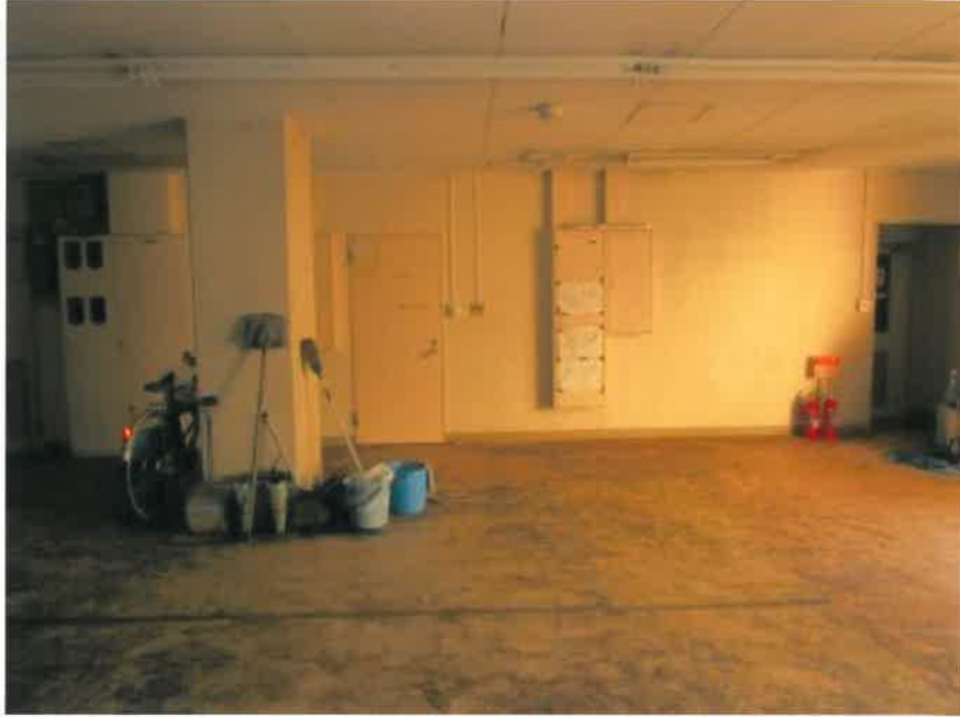
③ 建物内の状況
