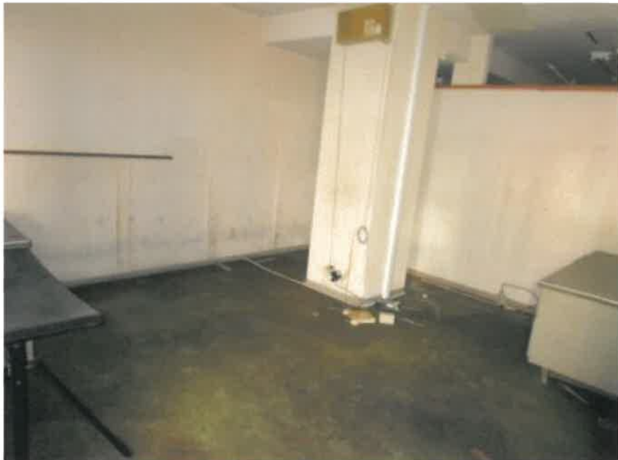
⑥ 建物内の状況
