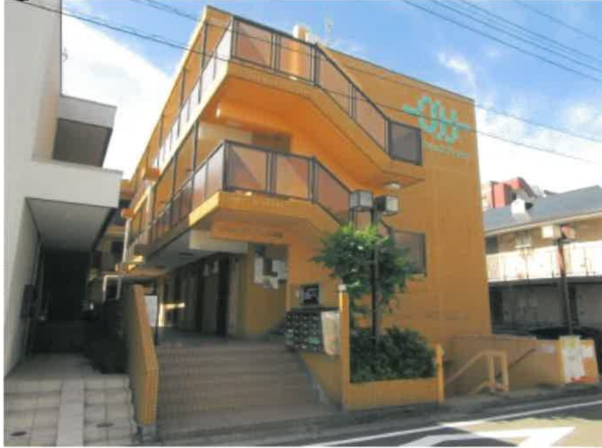
① 本建物を含む一棟の建物の外観（北東方向から撮影）
