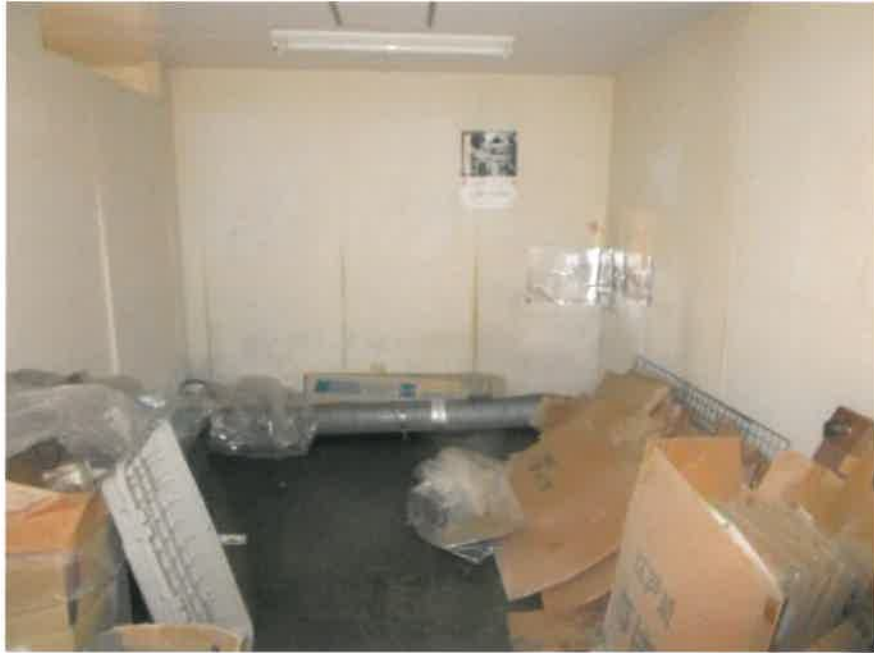
⑤ 建物内の状況
