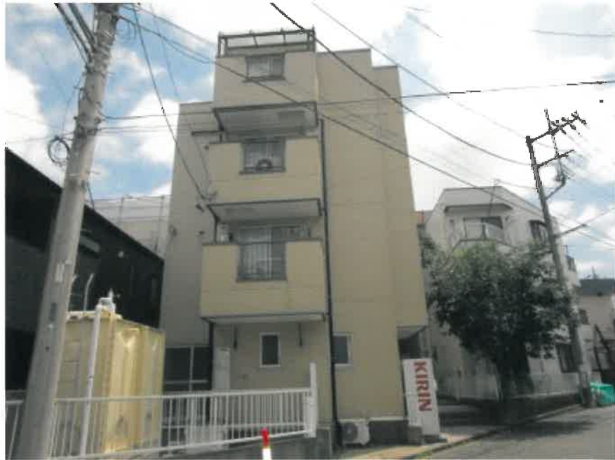
① 建物の外観
