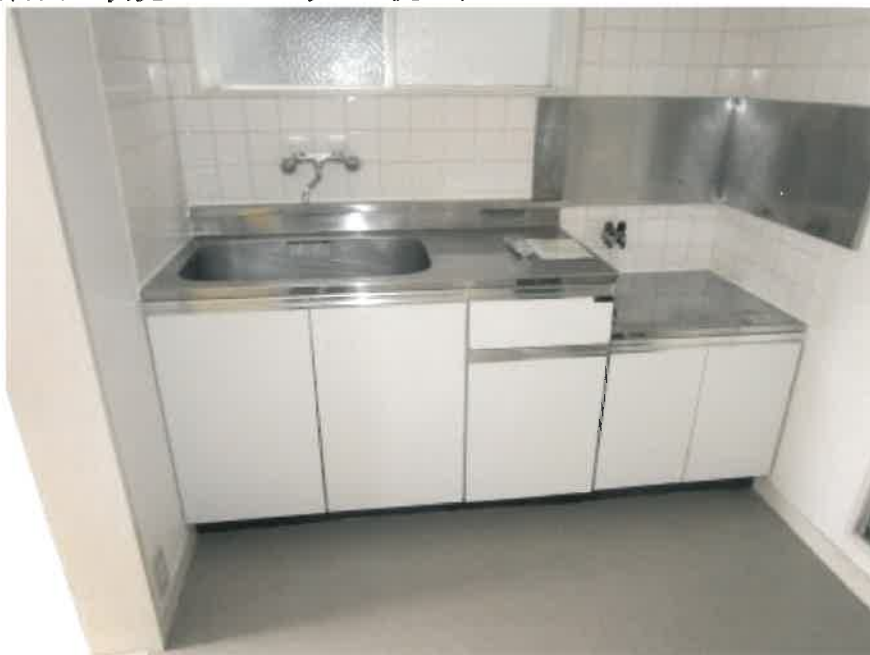
③ 建物内の状況 101号室 流し台
