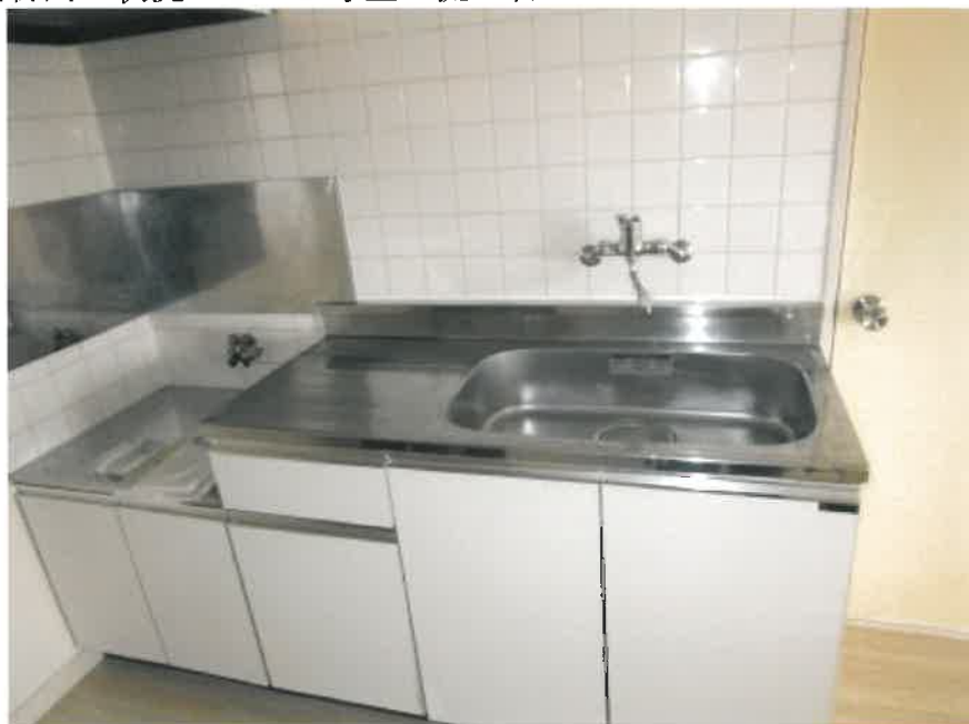
⑫ 建物内の状況 202号室 流し台
