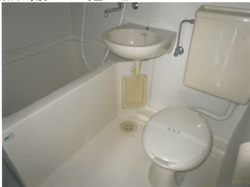
④ 建物内の状況 101号室 3点UB
