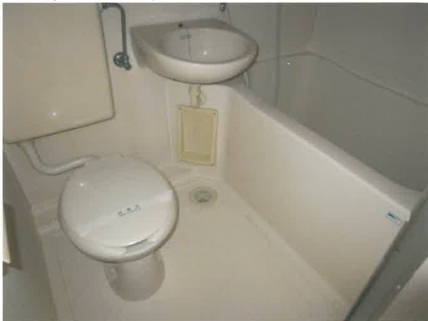
⑬ 建物内の状況 202号室 3点UB
