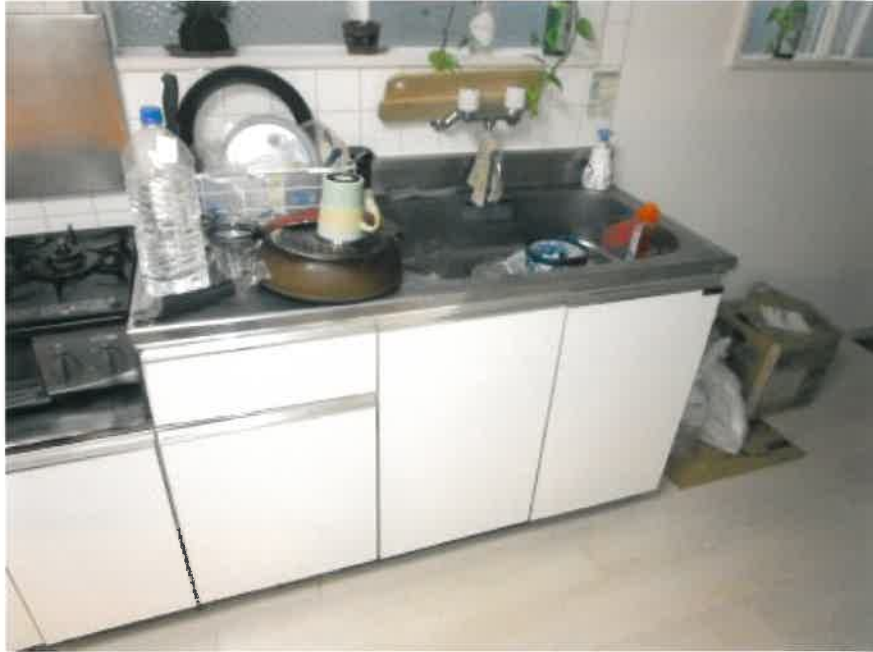
⑮ 建物内の状況 401号室 流し台
