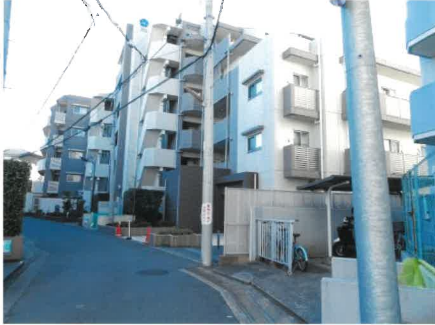
① 本建物を含む一棟の建物の外観（北東方向から撮影）
