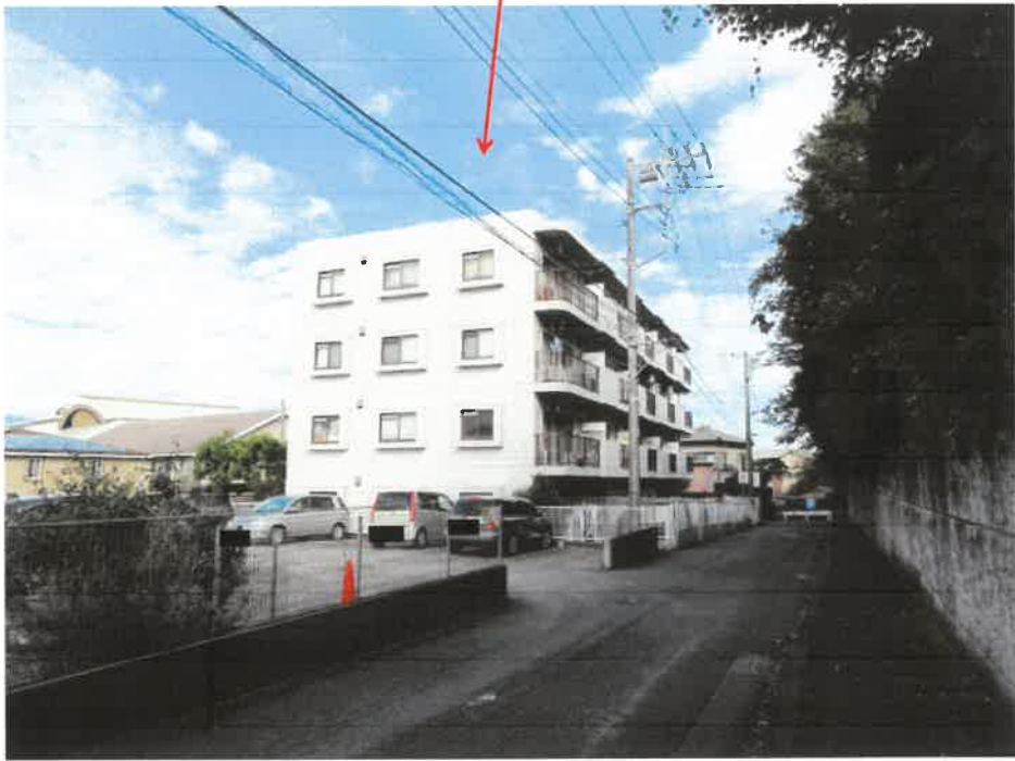
物件 1 の存する一棟の建物
