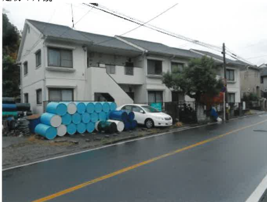
① 本建物の外観
