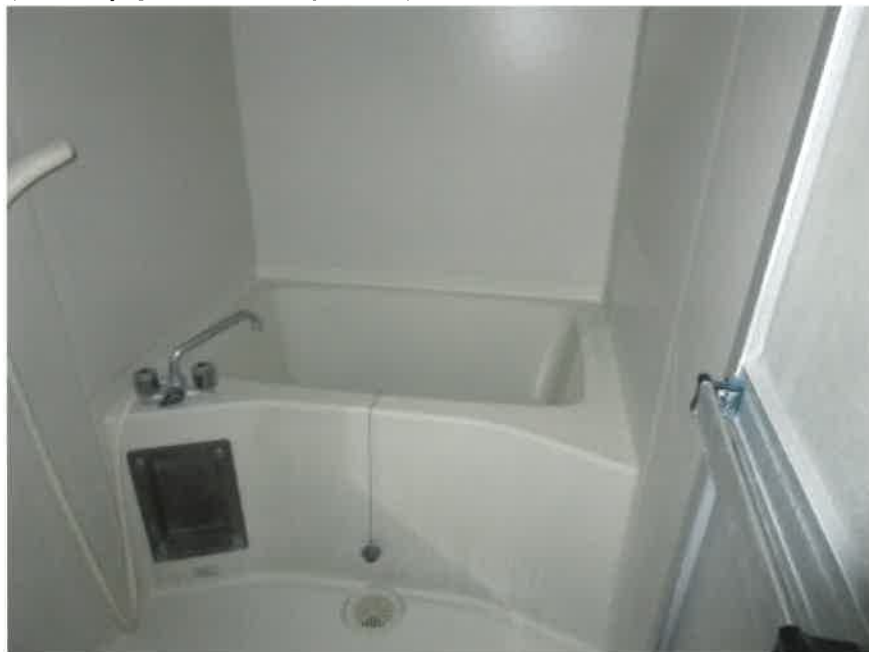
④ 建物内の状況 103号室 浴室
