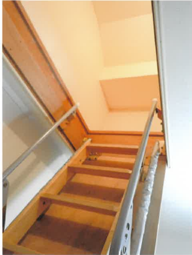
⑨屋根裏収納階段の状況
