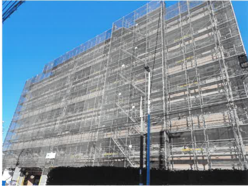
① 物件 1 建物外観（外壁工事中）
