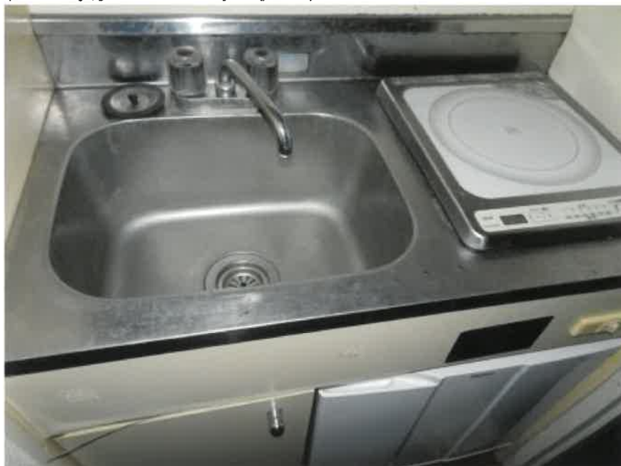
⑥ 建物内の状況 103号 流し台
