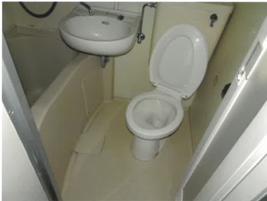
⑦ 建物内の状況 103号 UB
